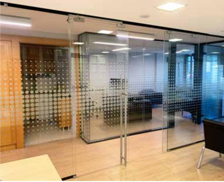
Verona sistem otomatik sürme kapı kapatıcı. Patentli pnömatik sistemi sayesinde kapının sürekli kapandığından emin olmanızı sağlar. İstenildiğinde stoplama noktasına getirilerek açık durması sağlanabilir. Şık kapak profili sayesinde gizli kullanılabilir.
